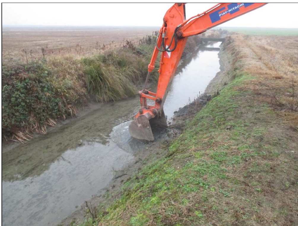
Figura 2 - Prelievo di materiale con escavatore nel letto del canale che, adeguatamente ampliato, andrà a costituire il nuovo scolmatore (21/11/2016 - pozzetto esplorativo pexp1).
